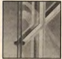
23. ábra Kedvezőbb árú az osztatlan, átmenő szigetelőüveg-lemez, felpattintott osztóléc-ráccsal, amely tisztításkor könnyen kivethető
